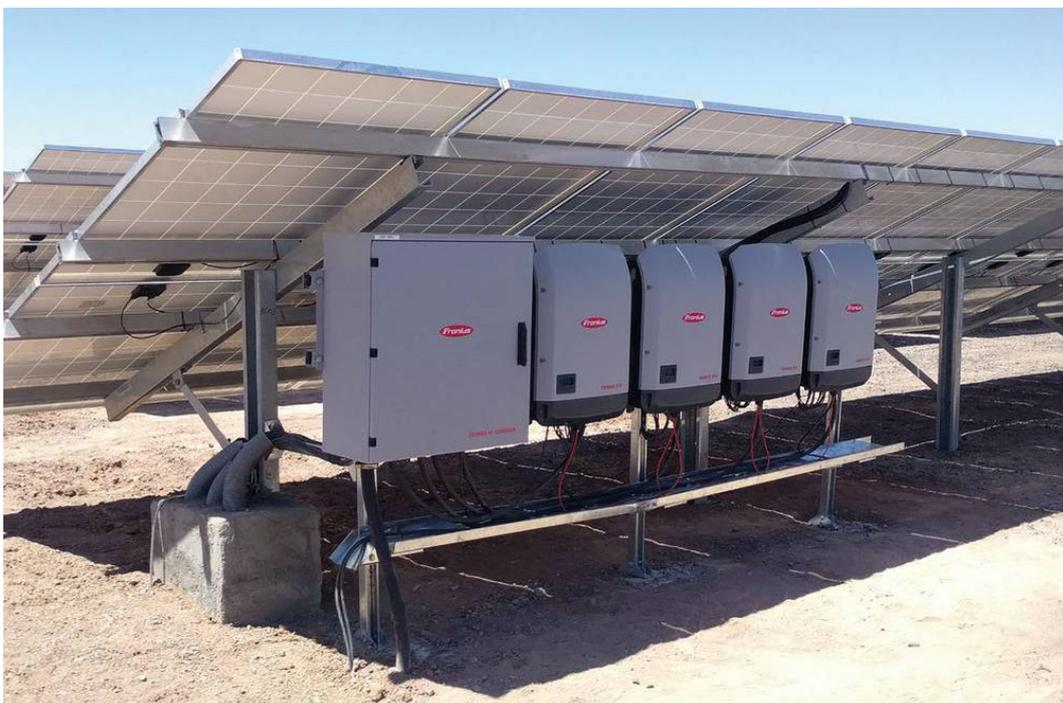
*Abbildung 3: Gruppenanordnung von Strangwechselrichtern in dezentralem Anlagendesign*
