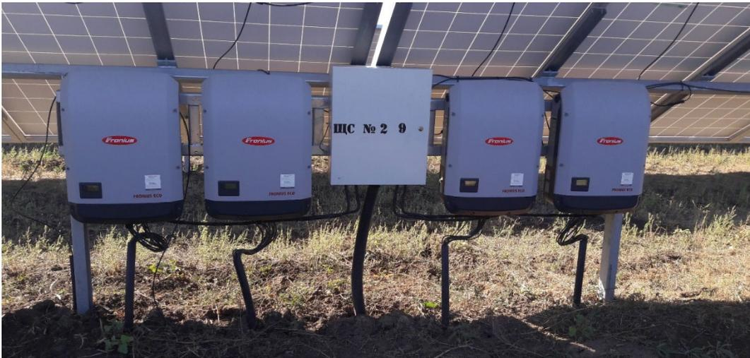
Abbildung 10: Beispiel der 4er Gruppierung der Wechselrichter - Anlage Tokmak (Quelle: Fronius)
