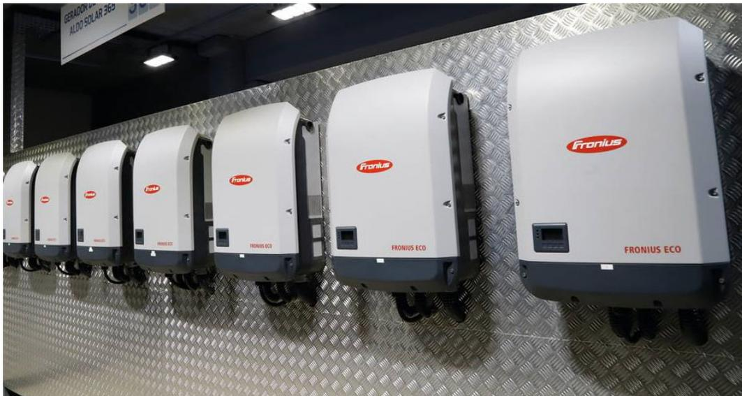
Abbildung 5: Zentrale Anordnung von Strangwechselrichtern in der Nähe der Hauptverteilung
