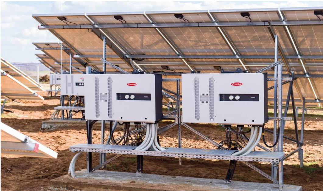
Abbildung 7: AC Daisy Chaining mit Fronius Tauro ECO bei dezentraler Gruppenanordnung
