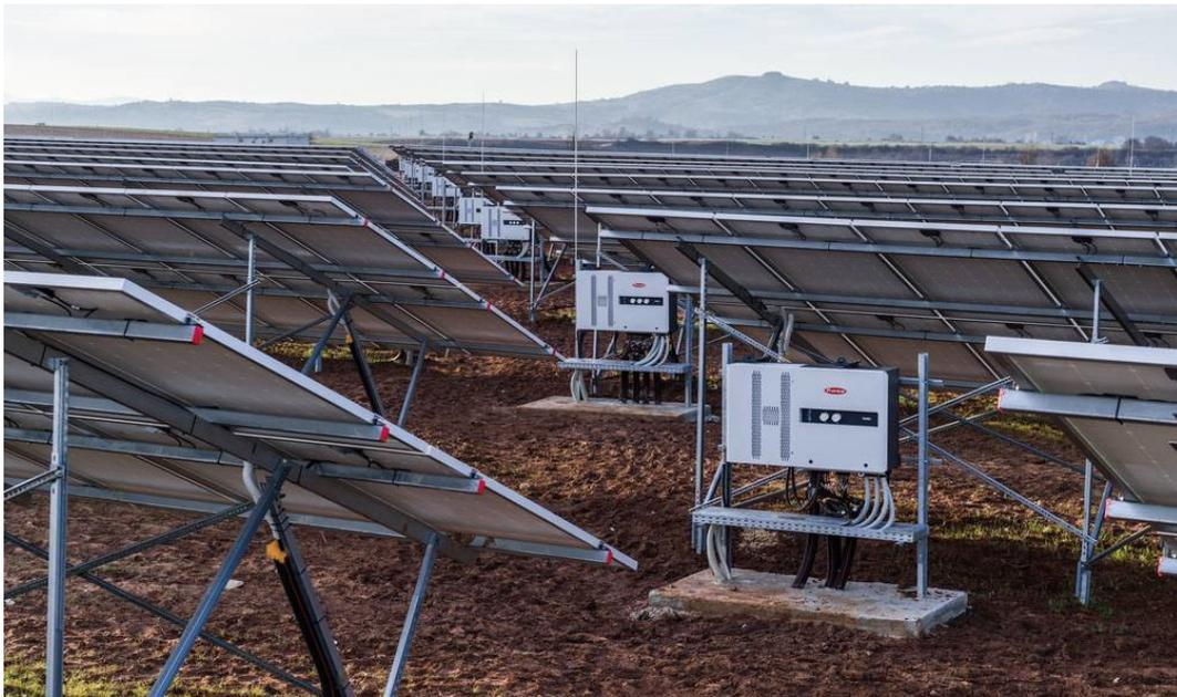
*Abbildung 2: Einzelanordnung von Strangwechselrichtern in dezentralem Anlagendesign*
